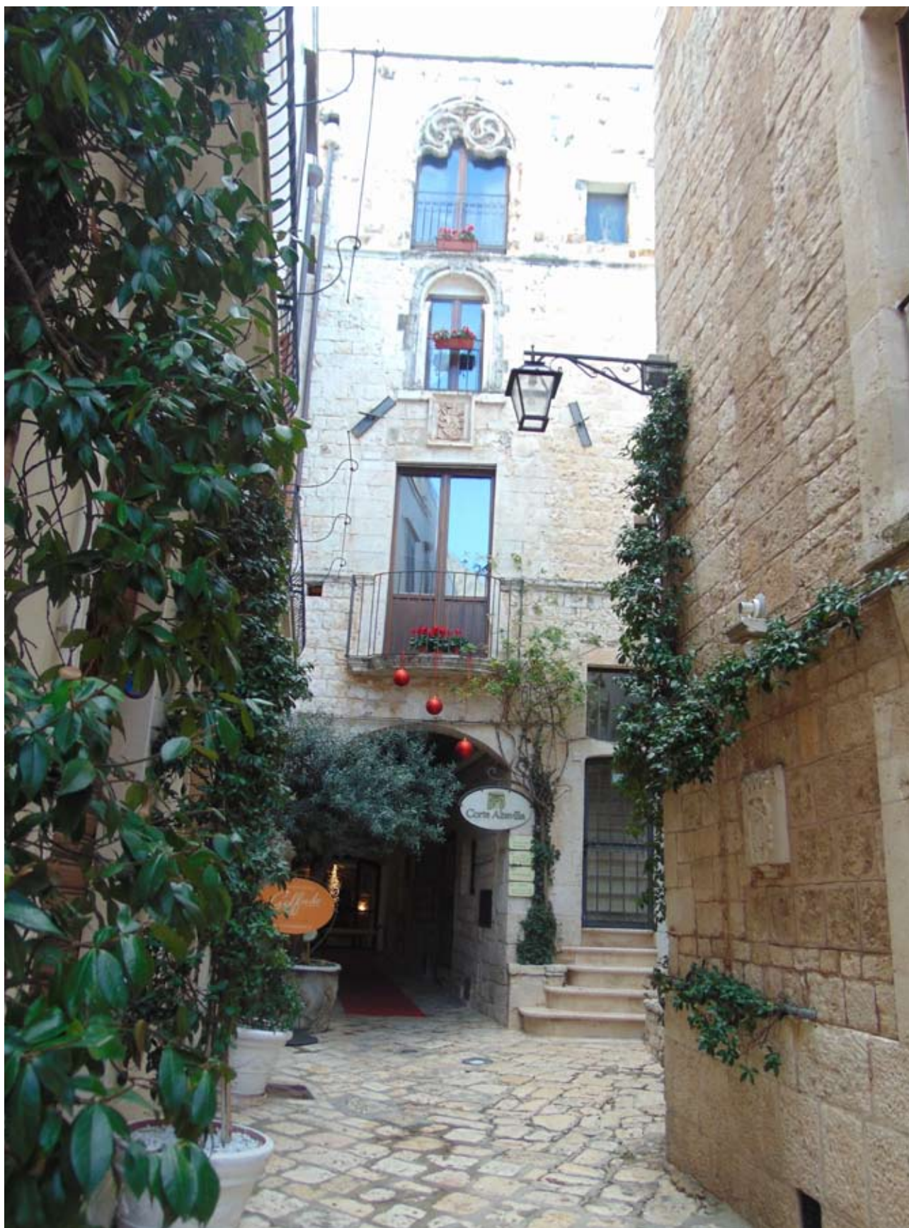
Palazzo di Giovanni Battista Esperti, in vico Goffredo Altavilla primo conte di Conversano (1068-1106), di fronte alla Cattedrale. (P.c. 451). Si ritiene essere stata la dimora del primo conte di Conversano. È la sola casa palazzata in Conversano su 4 piani fuori terra e con finestre bifore. Si noti lo stemma in pietra (sopra il balcone) tipico dei conti Altavilla e anche Bassavilla, che probabilmente era sopra il portale che, abbattuto, è stato successivamente denominato Arco Esperti. L'ingresso adattato è stato costruito nel secolo scorso alla sua destra. (Cfr. G. BOLOGNINI, Storia di Conversano , Bari 1935, p. 55).
