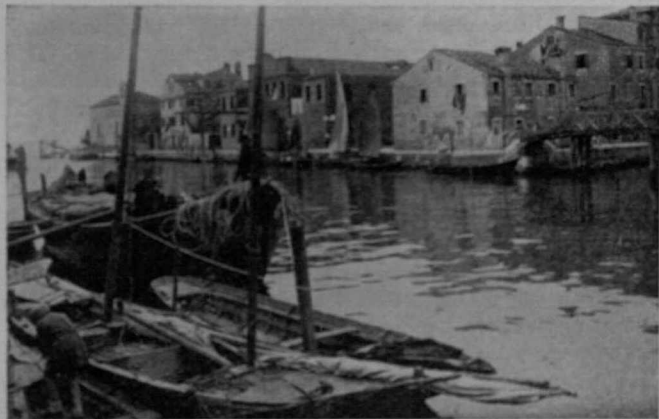
Il rio del Pontelongo verso la laguna - Nell'estremità la Chiesetta di S. Angelo.
