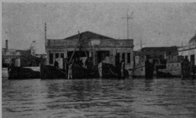
Cantiere "Marvi," - Alcune vedette costruite per il Ministero delle Finanze
