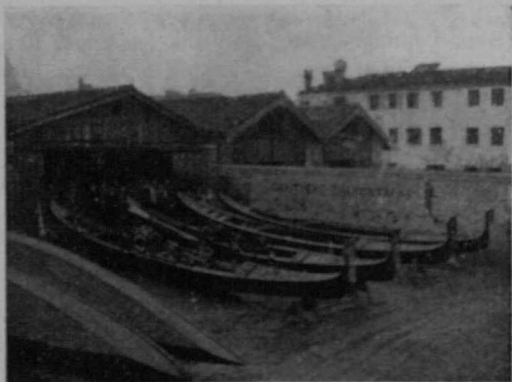
Il cantiere Tramontin
