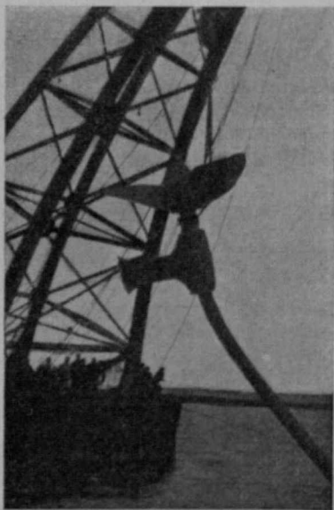
Salpaggio dell'elica della "B. Brin.", affondata a Brindisi
