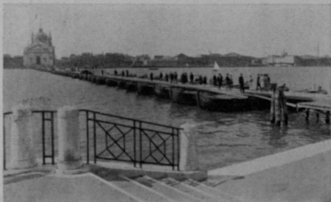
All'apertura del ponte
