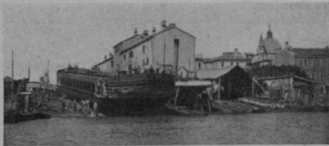
Il cantiere Cucco
