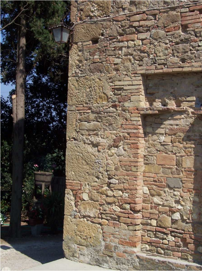
Fig. 34 - Sabbie plioceniche che costituiscono le pietre d'angolo di un edificio nei pressi di Sticciano
