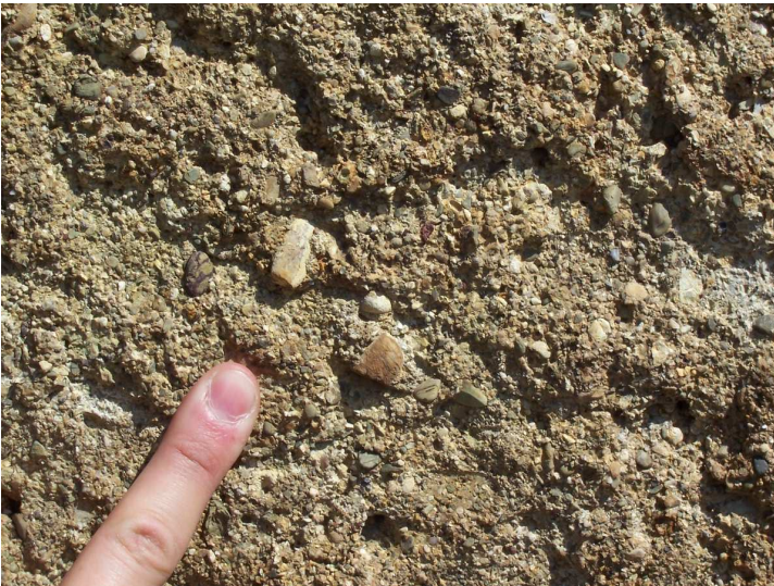
Fig. 35 - un concio di sabbia su un edificio nei pressi di Sticciano. Si nota la marcata variabilità granulometrica
