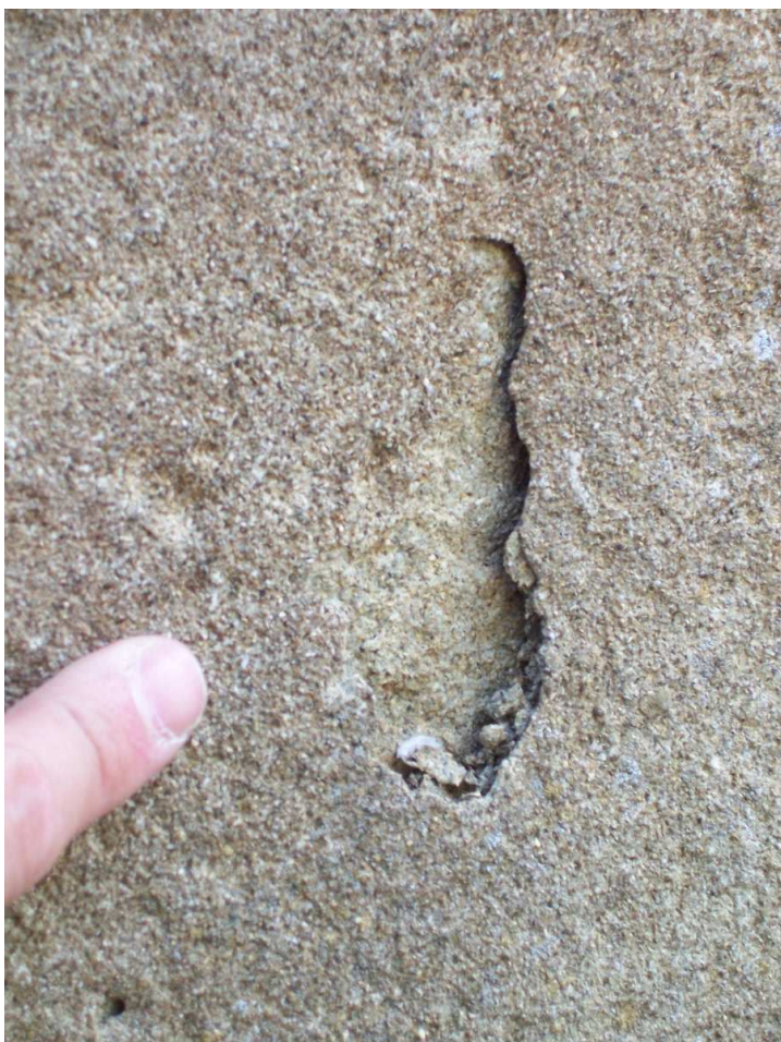
Fig. 39 - Particolare della crosta in corso di distacco da un concio di sabbia pliocenica
