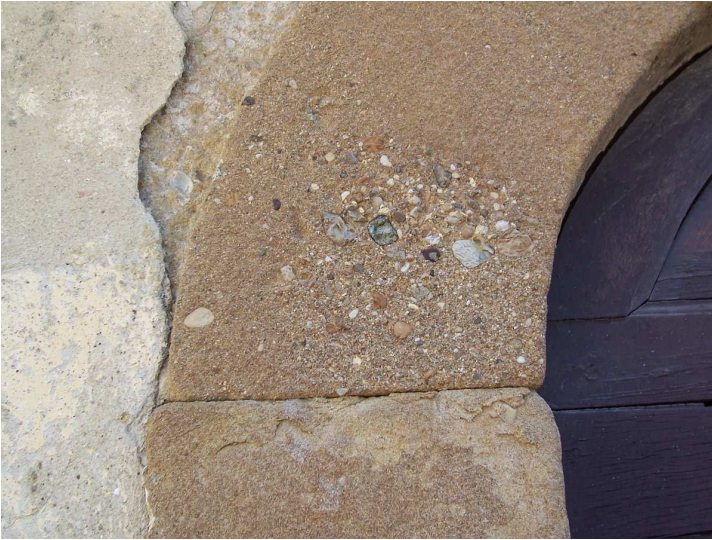
Fig 36 - Porzione di arco in un edificio nelle pertinenze della Villa di Sticciano. Anche qui è evidente la presenza di marcate variazioni granulometriche.
