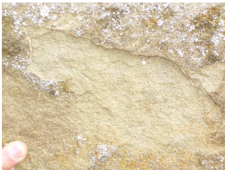
fig. 38 - Un concio di sabbie plioceniche che mostra evidenti segni di degradazione.
